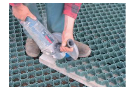
ACO Rasenwaben können mit handelsüblichen Geräten auf jede beliebige Größe geschnitten/gesägt werden.
